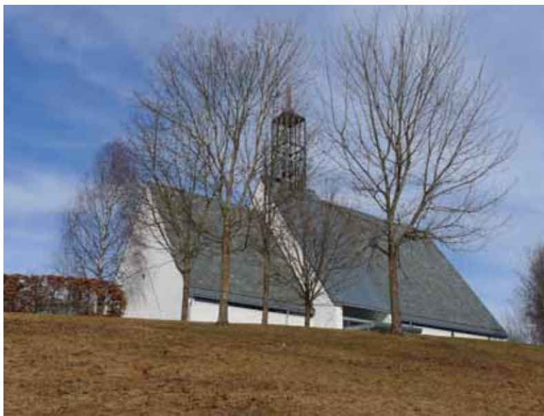
Under: Lommedalen kirke er et moderne kirkebygg med formmessig relasjon til tradisjonelle kirker. Det dominerende volumet er formet som et langskip og plassert i øst-vest retning. ASB
