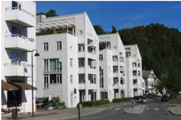
Til venstre: Boliger i Sandvika, tegnet av arkitektkontoret Kari Nissen Brodtkorb, ferdig år 2000. Boligene ligger mellom gamle villaer i sveitserstil og den funksjonalistiske Randersgården. Prosjektet formidler overgangen mellom de to med sitt eget uttrykk, allikevel tilpasset i fargebruk og proporsjoner. GM
