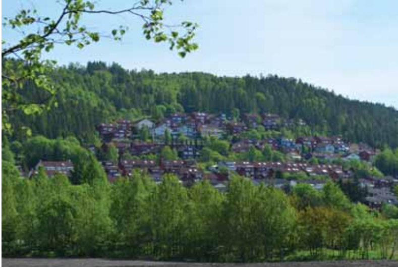
Over: Helset ble bygget ut med ca 700 boliger på 1980-tallet. Det bratte terrenget ga utsikt og gode solforhold. Utbyggingen var en helhetlig feltutbygging i privat regi. GM
