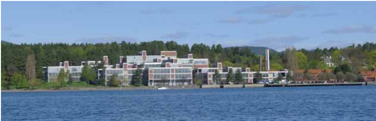
Nederst: Statoils nye regionkontor på Fornebu er et kontorbygg med 2500 arbeidsplasser. Bygget består av fem lameller sammensatt som en romlig skulptur. Hver lamell har tre etasjer. Tegnet av a-lab arkitekter. ASB
