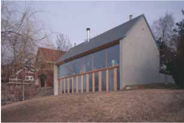
Øverst: Bolig på Strand tegnet av Jarmund/Vignæs Arkitekter. Eneboligen har en utradisjonell utforming med en "vridd" huskropp som skjermes mot omgivelsene og samtidig åpner opp mot lys og utsikt. ASB
