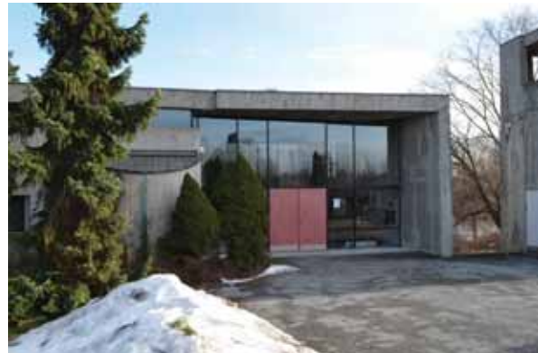
Nederst: Østerås kirke har en strengt geometrisk plan, med et sirkelformet, innadvendt kirkerom. Kirken er en arbeidskirke, hvor fleksibilitet i bruk har vært vektlagt. ASB
